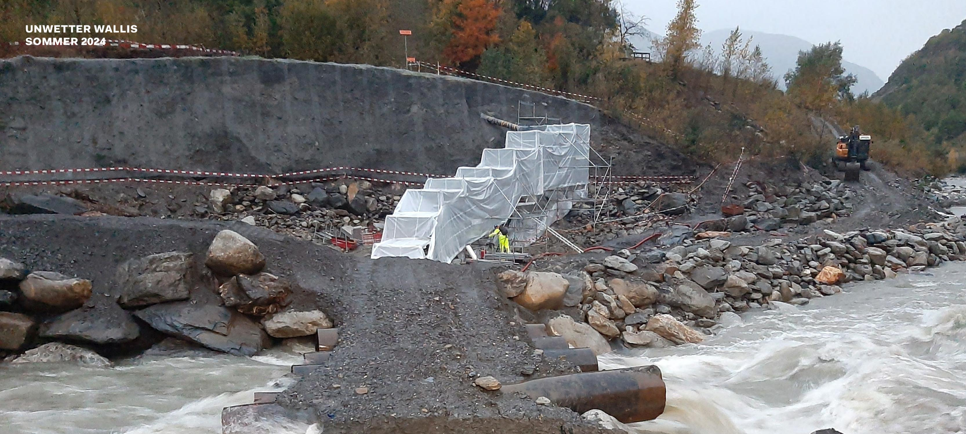
**OKTOBER** — Bau einer Furt und eines Schutzdammes im Düker Areal — Sicherung der Baustelle — Gerüstbau für äussere Integritätsprüfung der Rohrleitung — Geologie-erkundungen für zukünftige dauerhafte Varianten
