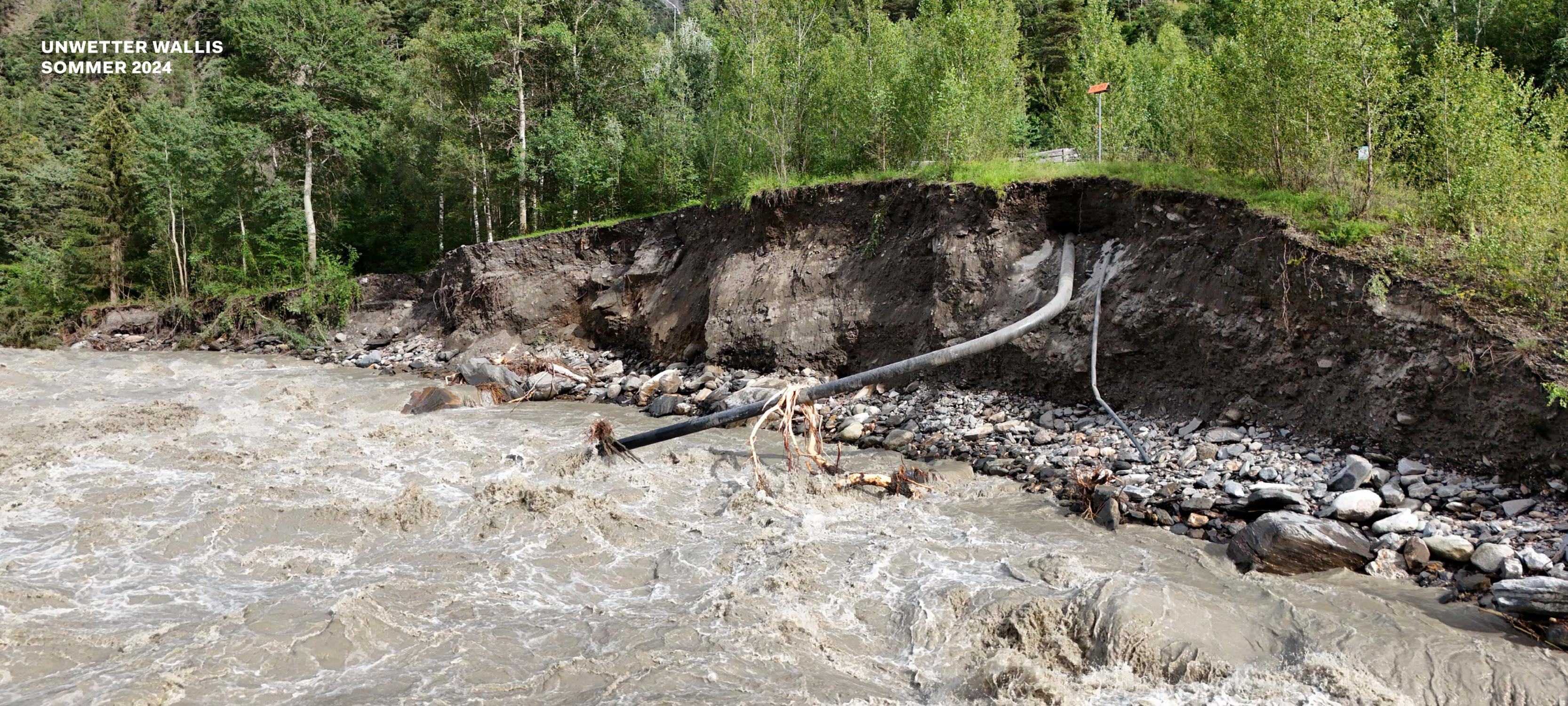
**SONNTAG, 30. JUNI** — Hochwasser erodiert 250 Meter der Uferböschung der Rhone — Freispülung der Zuleitung zum Düker Mörel — Ausserbetriebnahme des Abschnittes Grengiols–Naters — Zusammenstellung von Team und Ressourcen
