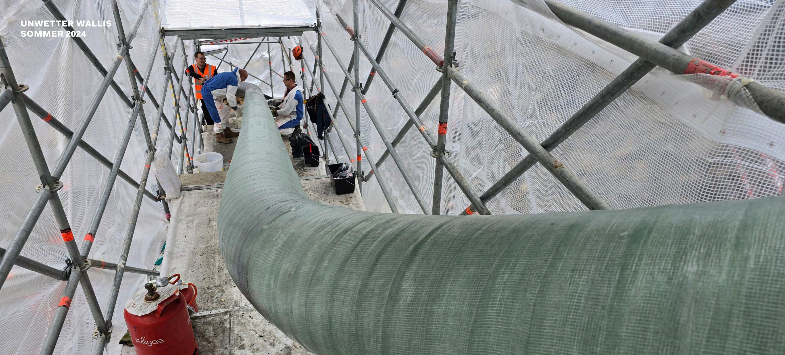
**ENDE OKTOBER** — Äussere Integritätsprüfung der Rohrleitung Düker — Entfernung PE-Umhüllung — Zerstörungsfreie Rissprüfung — Beschleifen der Kratzer — Anbringen PE und GFK Umhüllung
