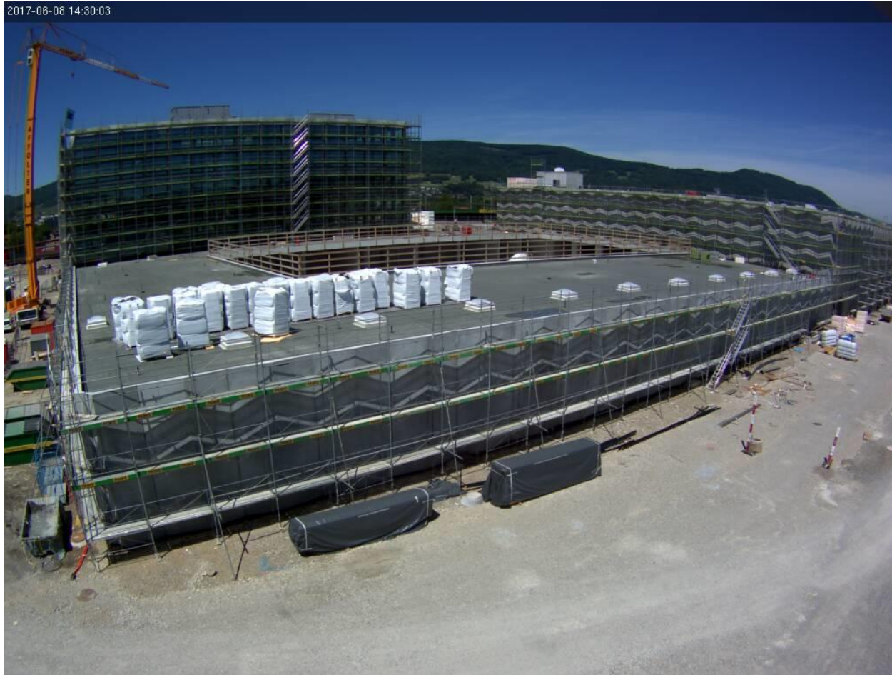
Photo: webcam du chantier IBAarau
